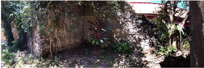
Figura 2 – Condições das ruínas do Forte do Raio
