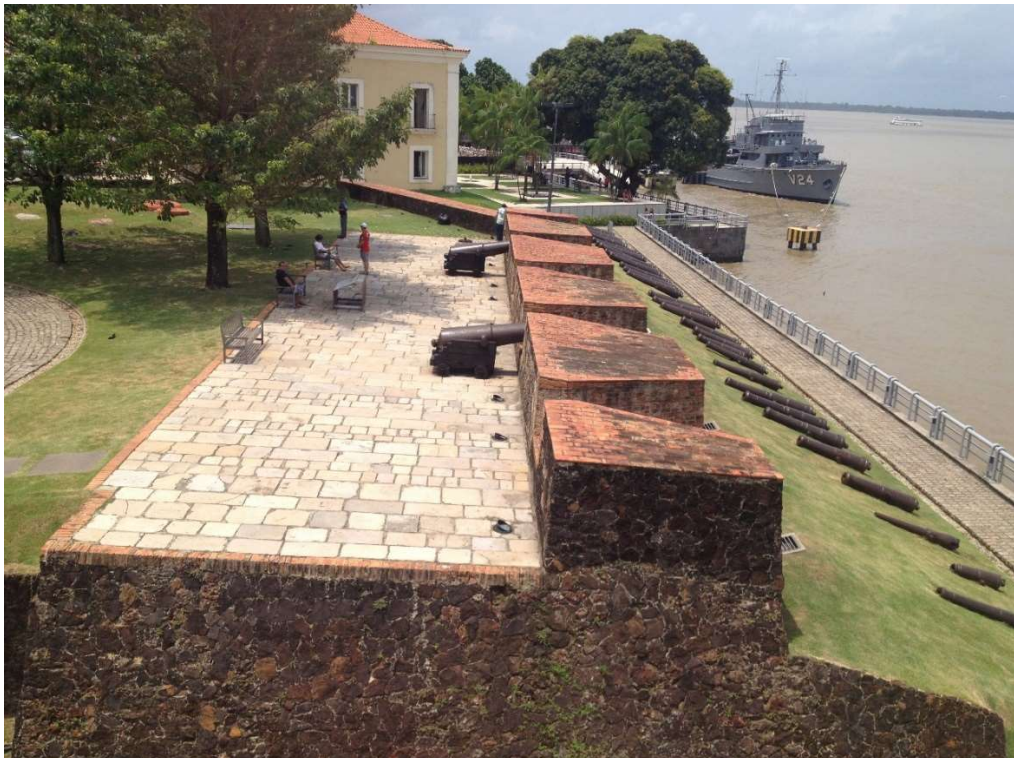
Figura 8: Vista lateral da artilharia do Forte do Presépio, Belém, Pará.
